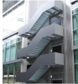
*Bild links: Im Saarland vorproduzierte und dort zunächst zwischengelagerte Treppen, wie diese außen- und innenverlaufende Sonderkonstruktion für das Audi-Auslieferungszentrum in Neckarsulm, werden termingerecht zu Bauprojekten geliefert und vor Ort montiert*
