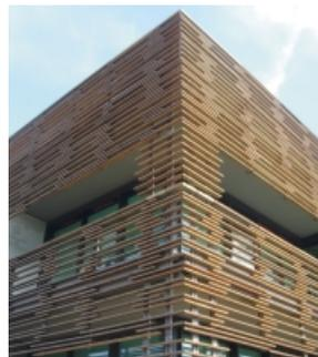
*Bild links: Metall-Holzfassade für das neue Hotel „Seezeitlodge“, das zur Zeit am Bostalsee entsteht*
