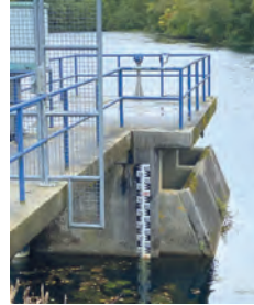
Bilder oben und links: Innovative Sensortechnik von dimeto erhebt u.a. Umweltdaten, wie Regen und Hagel, oder hilft bei der Messung von Pegelständen bei Gewässern.
