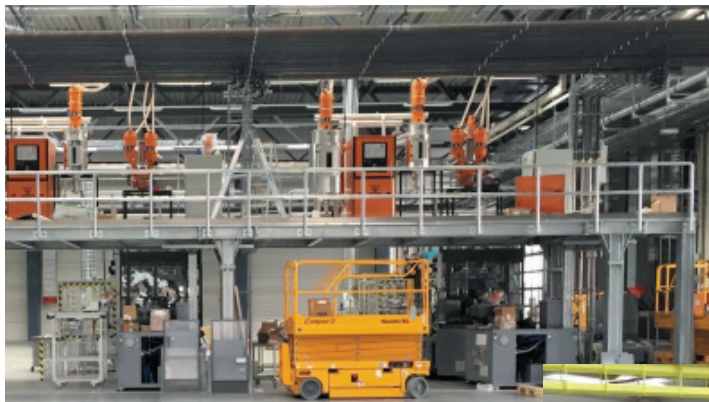
Für den Getränkehersteller HANSA-HEEMANN AG in Bruchsaal hergestellte Stahlbühne, die die Höhe der Produktionshalle optimal ausnutzt
